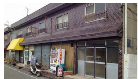
リノベーションを行う前の建物の様子
