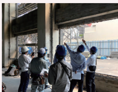
解体現場での構造確認
