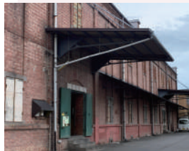
煉瓦造の旧銀行倉庫（前橋市）
